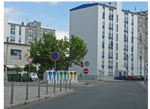
Reabilitação de edifício do Bairro Crítico Vale da Amoreira—Lisboa (www.google...)
